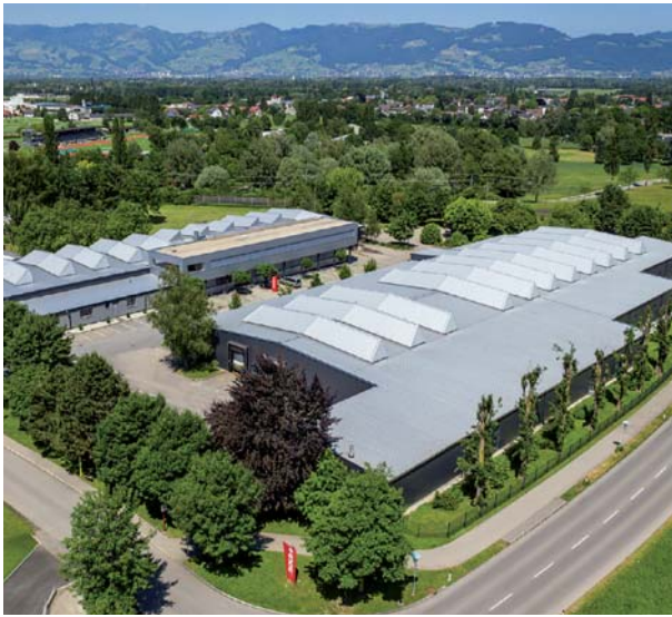
Завод 1, 2 и 3, Форарлберг, Гьоцис
